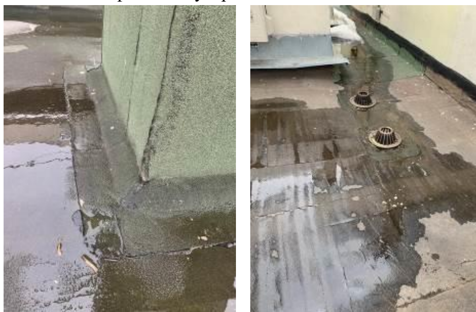
Фото 7-8. Наличие следов намокания.
